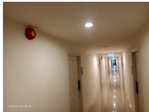
หลอดไฟ LED แบบเปิดสลับดวง
