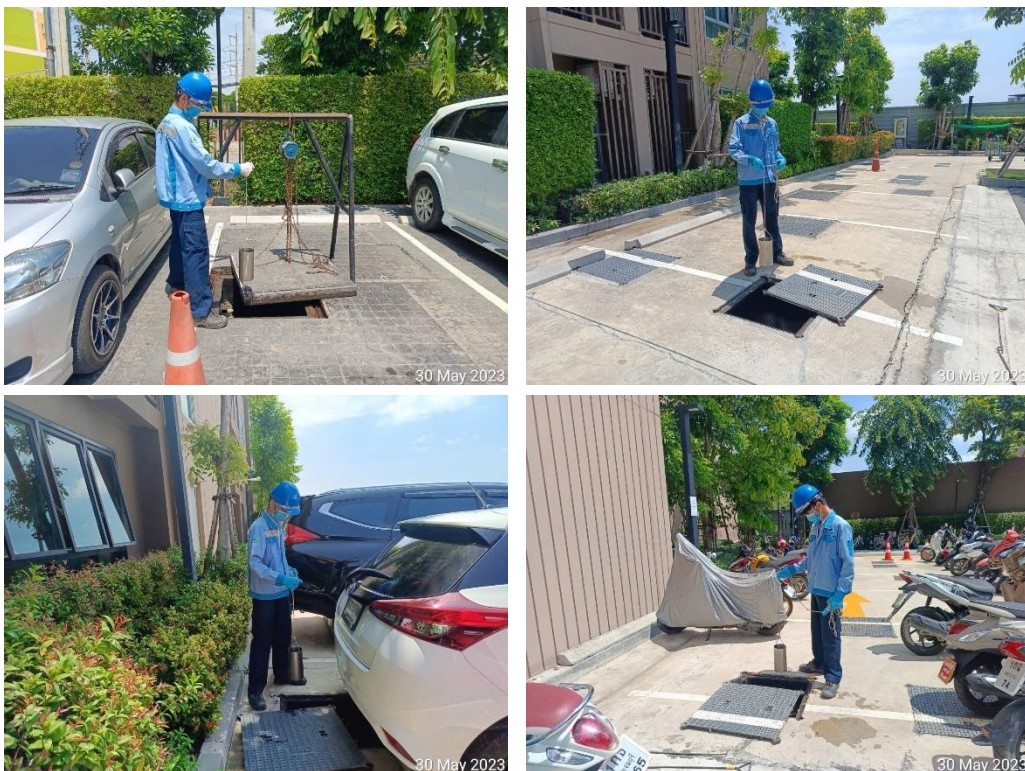
ภาพที่ 3.5.4-1 การเก็บตัวอย่างน้ำของระบบบำบัดน้ำเสีย
